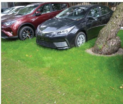
*Sudspave-Elemente, die sich nahtlos in den Rasen einfügen. Sie bieten eine langlebige und wasserdurchlässige Oberflächenlösung*
