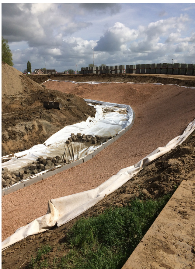
Stratex Premium Les géotextiles utilisés dans la construction des digues empêchent le mouvement des particules du sol (renard hydraulique). Le renard est le phénomène de transport de particules du sol par infiltration d'eau, créant des ouvertures tubulaires sous la digue.
