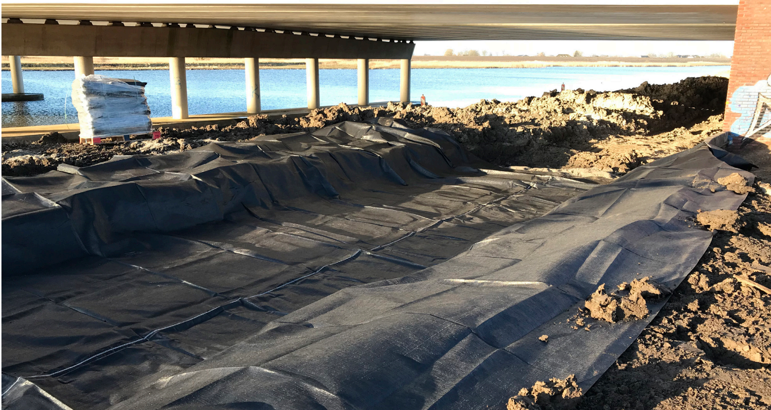
Stratex B Dans les fondations de nouvelles constructions routières, des géotextiles sont utilisés pour la séparation et la filtration afin d'éviter le mélange des matériaux granulaires. La durée de vie des routes s'en trouve prolongée.
