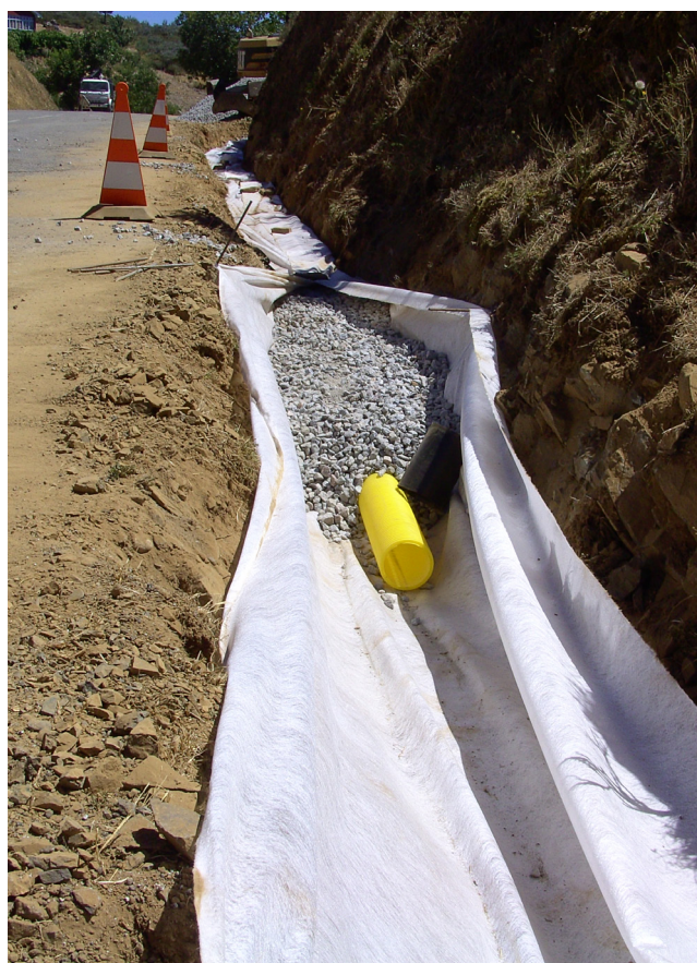
Stratex Premium Enveloppé autour des « drains français » (en pierres sèches), le géotextile Bontec agira comme une couche filtrante, réduisant le besoin de matériau granulaire et empêchant les remblais de se colmater.
