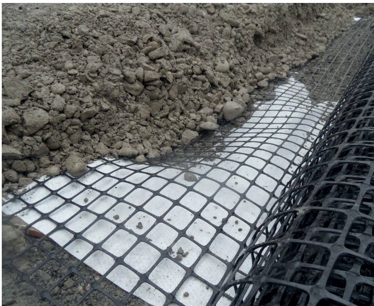
Géogrille Geogitter StratexGRID 3D PRO
